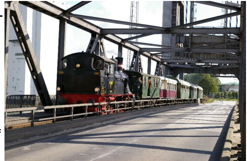
Foto: Thomas Hartleff, Dampflok Karoline auf der Rethehubbrücke, 09.09.2007
